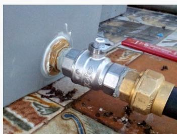
Alcuni installatori per ovviare al problema delle perdite legato a questo tipo di raccordo, utilizzano del sigillante silconico sia all'esterno che all'interno del serbatoio. Questo tipo di sigillante è altamente tossico, soprattutto quando viene impiegato in serbatoi contenenti acqua potabili. Può causare a lungo termine lo sviluppo di varie malattie fra cui il cancro non solo nell'uomo ma anche negli animali.
